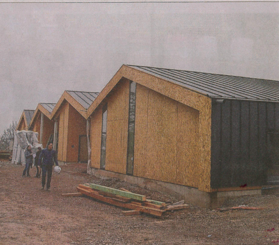
fera par l'arrière du bâtiment. Elle sera sécurisée par un visiophone. Un parking et béton vont être aménagés ainsi qu'une aire de jeux et un potager. Photo Pierre HECKLER.
